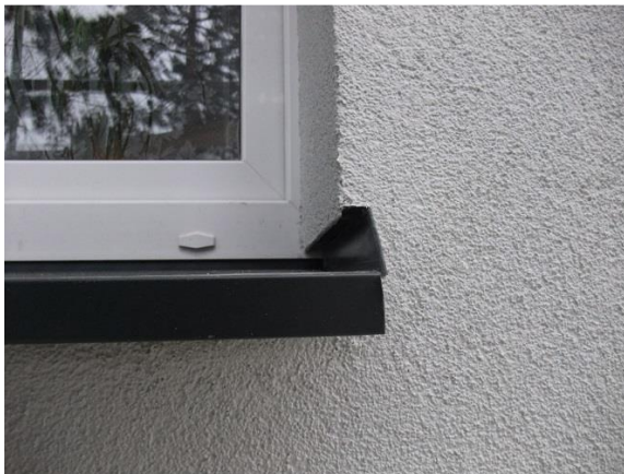
Obrázek 2 Detail zatažení parapetního plechu do ostění
